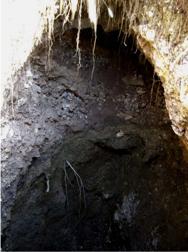
Pormenores do buraco gerado por assentamento e movimento subterrâneo de água (Figuras 3 e 4)
