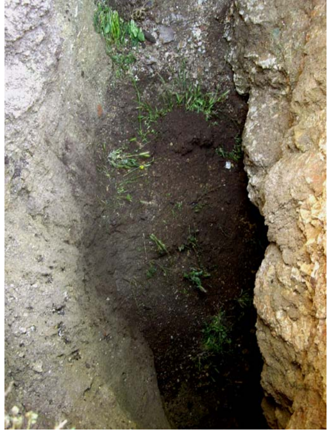
Pormenores do buraco gerado por assentamento e movimento subterrâneo de água (Figuras 3 e 4)
