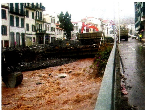
Foto 8 – Colmatção total da ribeira de Santa Luzia com consequente transbordo – Funchal
