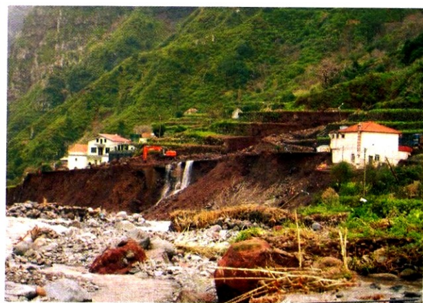
Foto 2 – Depósito de vertente antigo consolidado, parcialmente removido pelo regime torrencial da ribeira. Sítio da Serra de Água – Ribeira Brava
