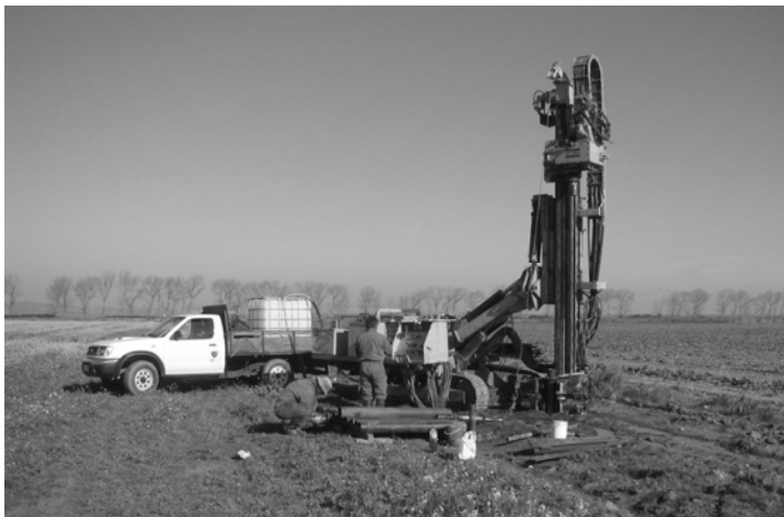
Figura 2 – Equipamento de sondagem equipado com amostrador triplo Geobor S
