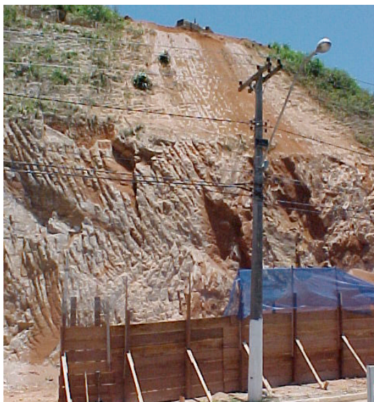
Figura 1 - Perfil de alteração da área de escavação
