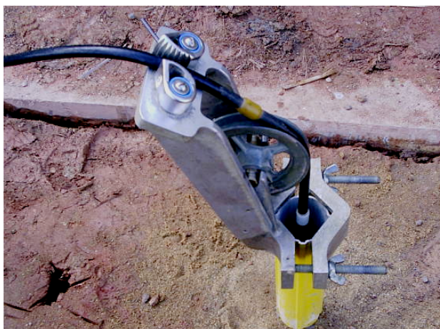
Figura 3 - Inserção do inclinômetro para monitoramento dos deslocamentos horizontais
