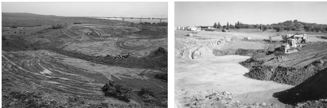
Figura 5 – Modelação dos terrenos de fundação do depósito de resíduos e das lagoas de tratamento
