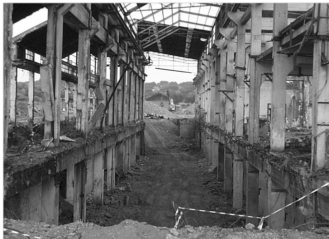
Figura 4 – Saneamento das fundações das caves da fábrica da Portucel Recicla
