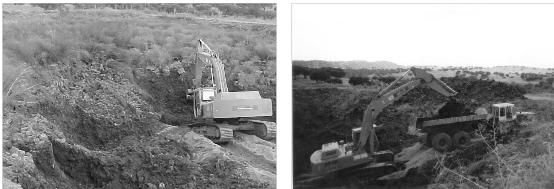
Figura 3 – Remoção de lamas dentro das lagoas de tratamento
