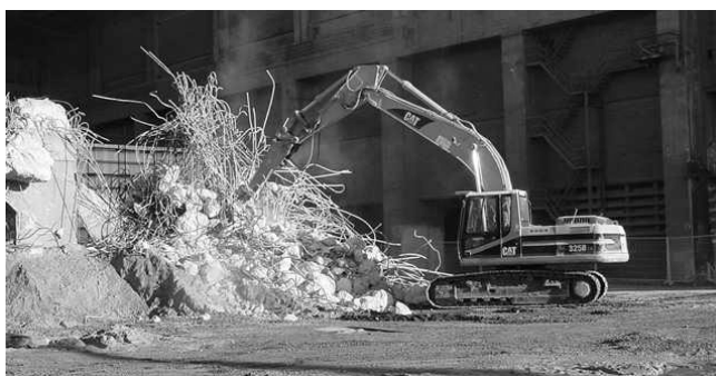
Figura 2 – Demolição selectiva – separação de materiais (Fábrica da Portucel-Recicla)
