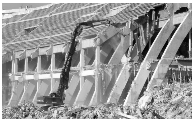
Figura 9 – Demolição selectiva no estádio da Luz
