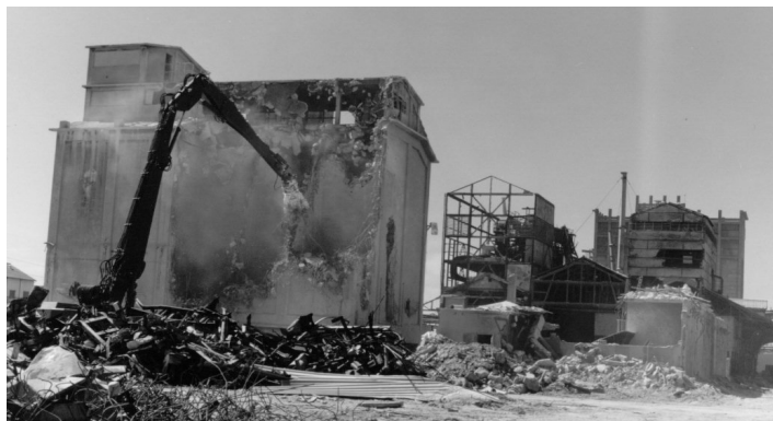
Figura 6 – Demolição das fábricas de adubos do Barreiro
