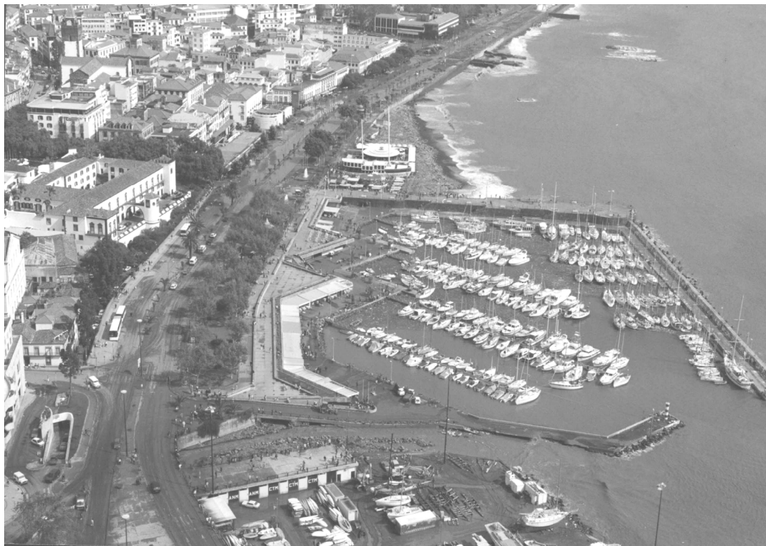
Figura 10 – Vista Poente da baixa do Funchal entre o curso inferior da Ribeira de São João (zona central na parte inferior da fotografia), Marina, Cais e foz das ribeiras de Santa Luzia e de João Gomes, após a aluvião de 29 de Outubro de 1993.
