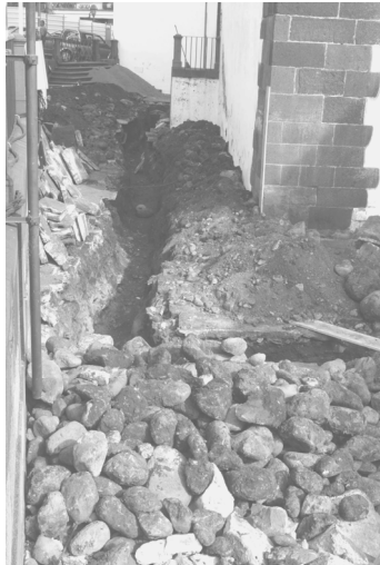
Figura 2 – Vala aberta no alçado Norte da Sé do Funchal onde é possível observar a heterogeneidade e a fraca coesão dos materiais geológicos aluvionares. © João Baptista, 2004
