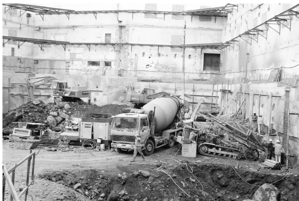
Figura 4 – Escavação e execução de paredes moldadas e ancoragens nos terrenos aluvionares da Antiga Companhia Insular de Moinhos, na Rua do Hospital Velho. © João Baptista, 2004
