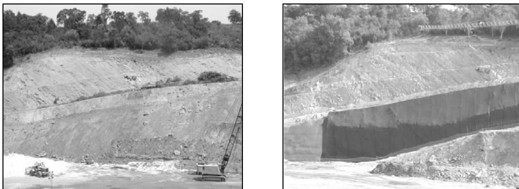
Figura 8 - Vista da escavação para o descarregador de cheias
