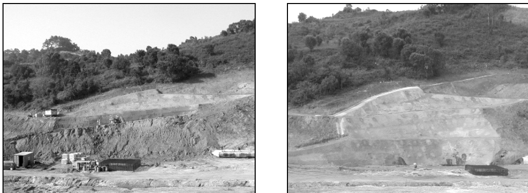
Figura 7 - Vista da escavação para a torre de tomada de água
